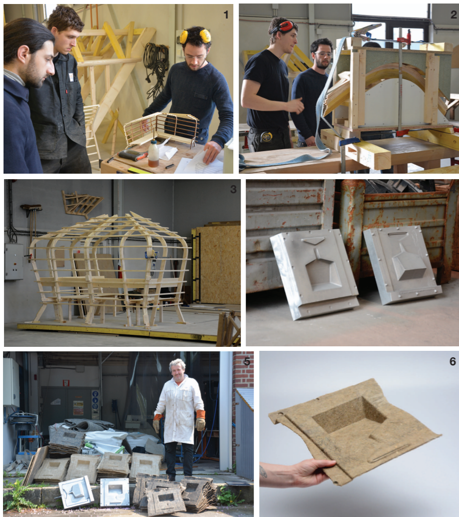
1-3. Fabrication de la charpente, en épicéa massif et lamellé-collé, à l'atelier des Compagnons du Devoir de Muizon.
