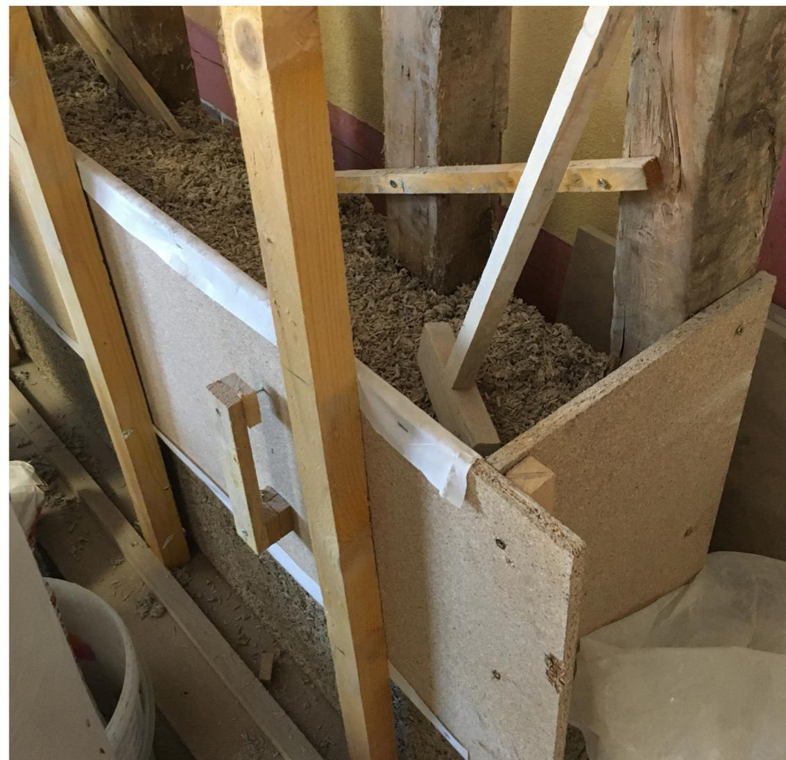
principe de coffrage pour un mur en béton-chanvre, intégrant des pans de bois
