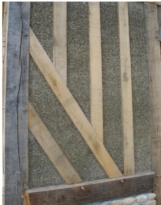
photo de charpente et béton chanvre
