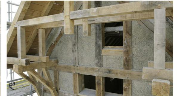
facade en béton-chanvre en cours de réalisation
