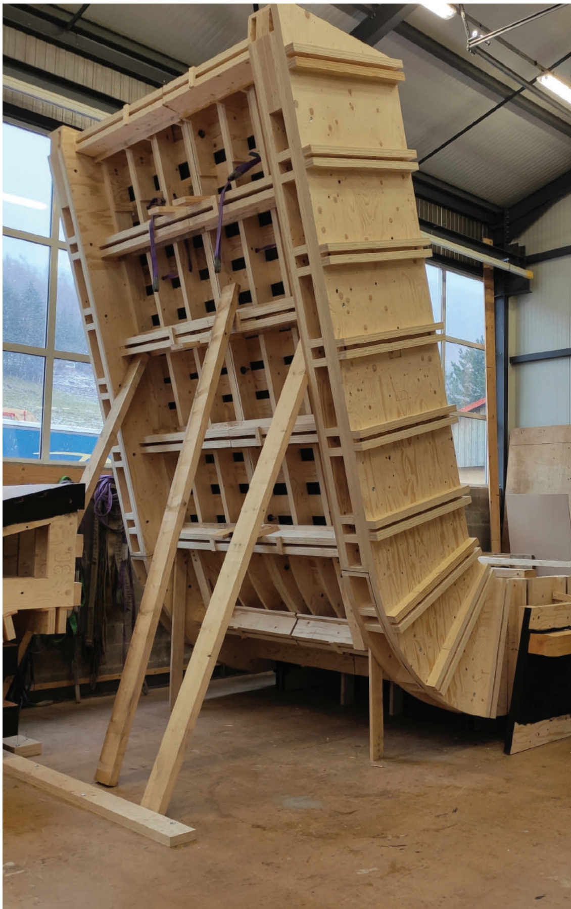
Coffrage réalisé par l'entreprise
