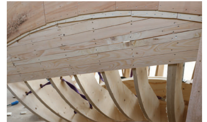
Détail de l'assemblage
