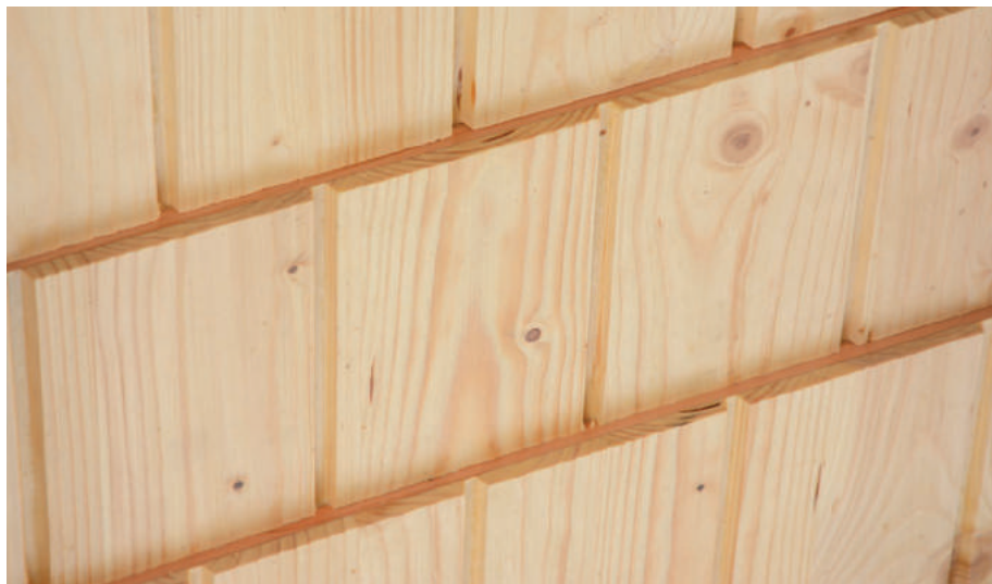
Détail des essis à l'intérieur du coffrage
