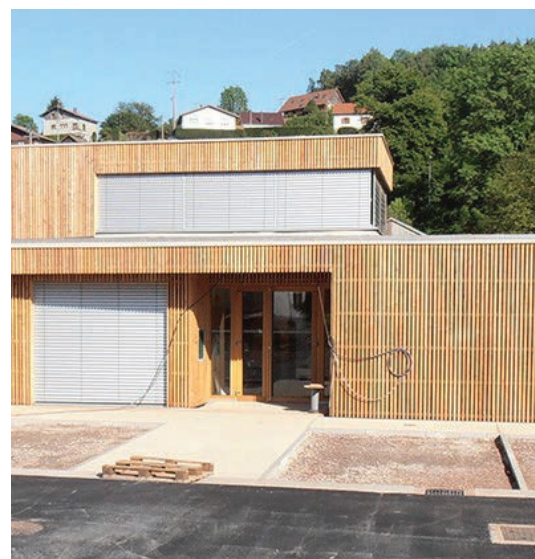
Menuiserie extérieure, bardage.*
