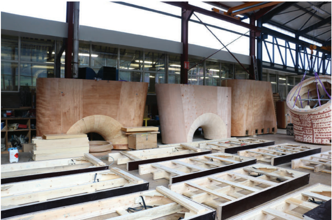
Atelier d'assemblage de l'entreprise Hans coffrage.
