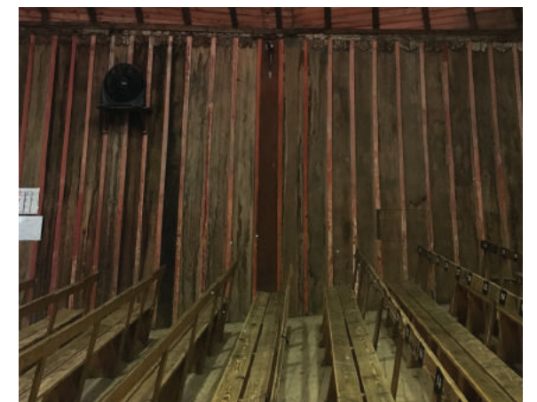
Placage bois pour les murs de la salle.
