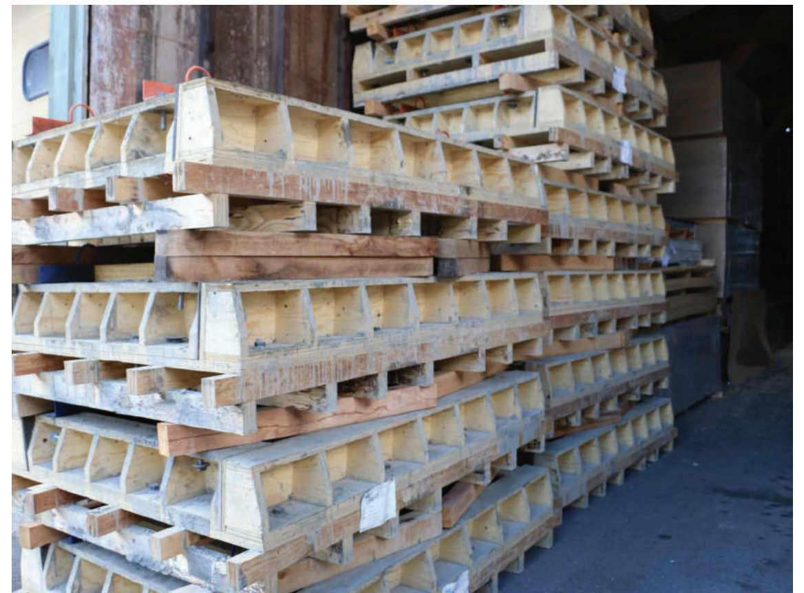
Coffrages stockés en vu d'une prochaine utilisation
