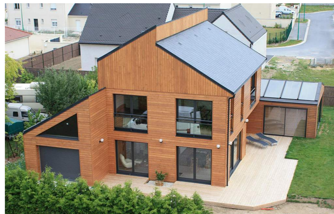
Réalisation de l'entreprise LDM - Construction bois, installée à Prouilly (51)
