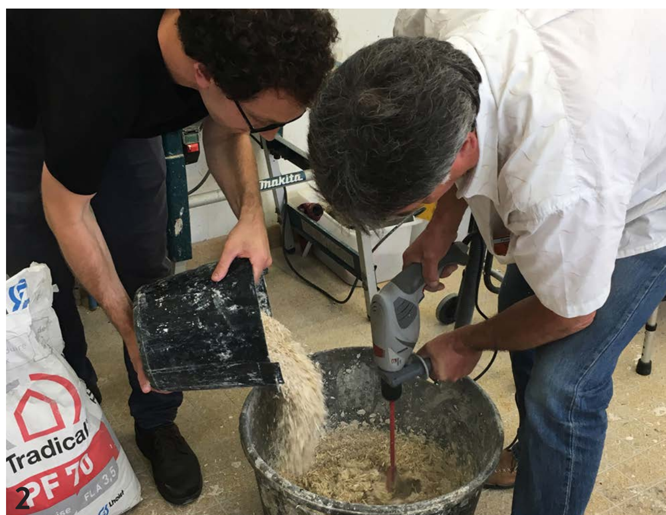
1. Découverte du terrain - visite de La Chanvrière et de la Maison du Tourisme de Troyes, bâtiment démonstrateur entièrement renové en béton chanvre. 2. Phase d'apprentissage avec le responsable technique de BCB Tradical.
