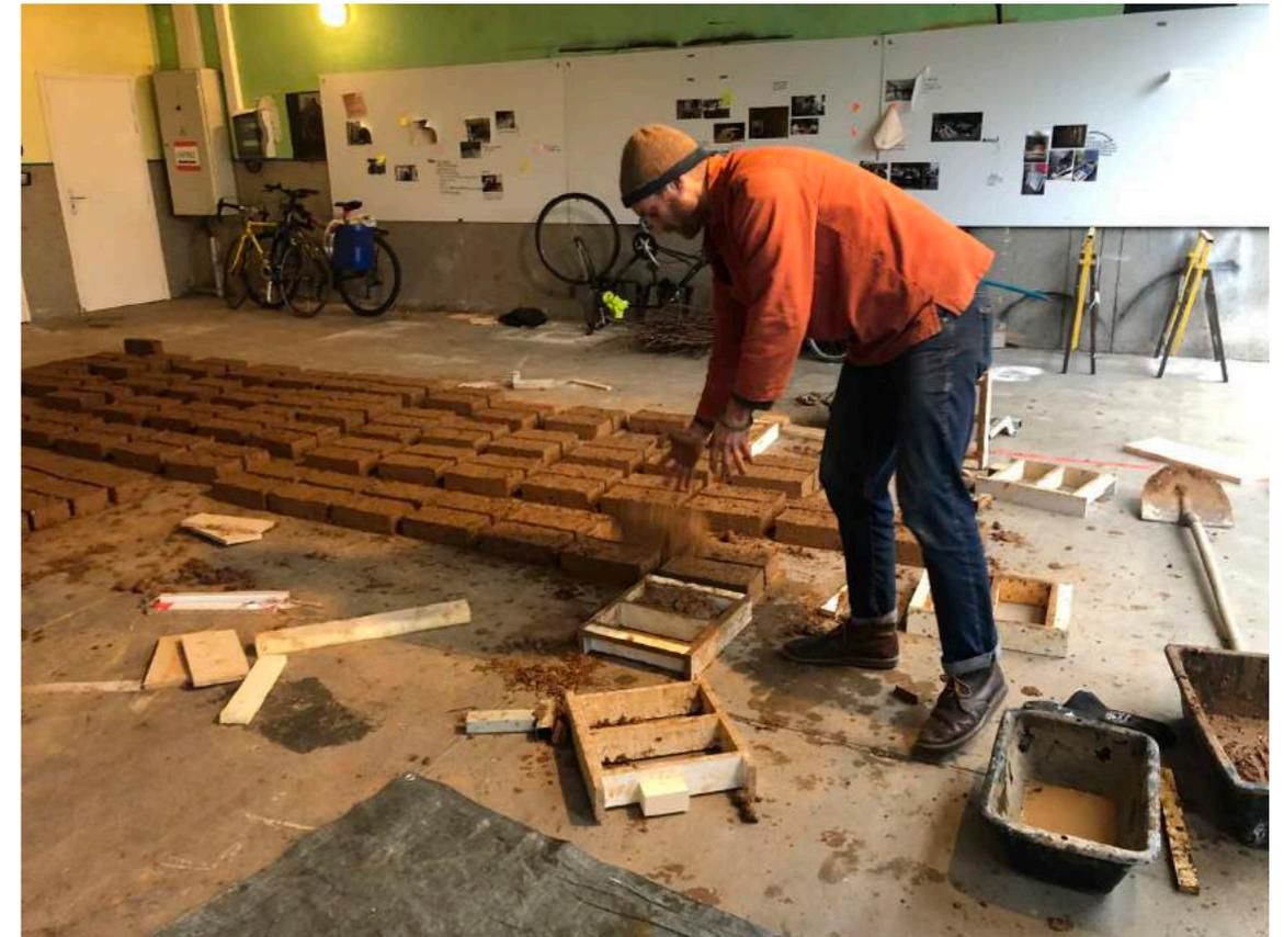
3. Jeté du p $\hat{a}$ ton dans le moule permettant une plus grande compression dans le moule et facilitant la prise de forme.
