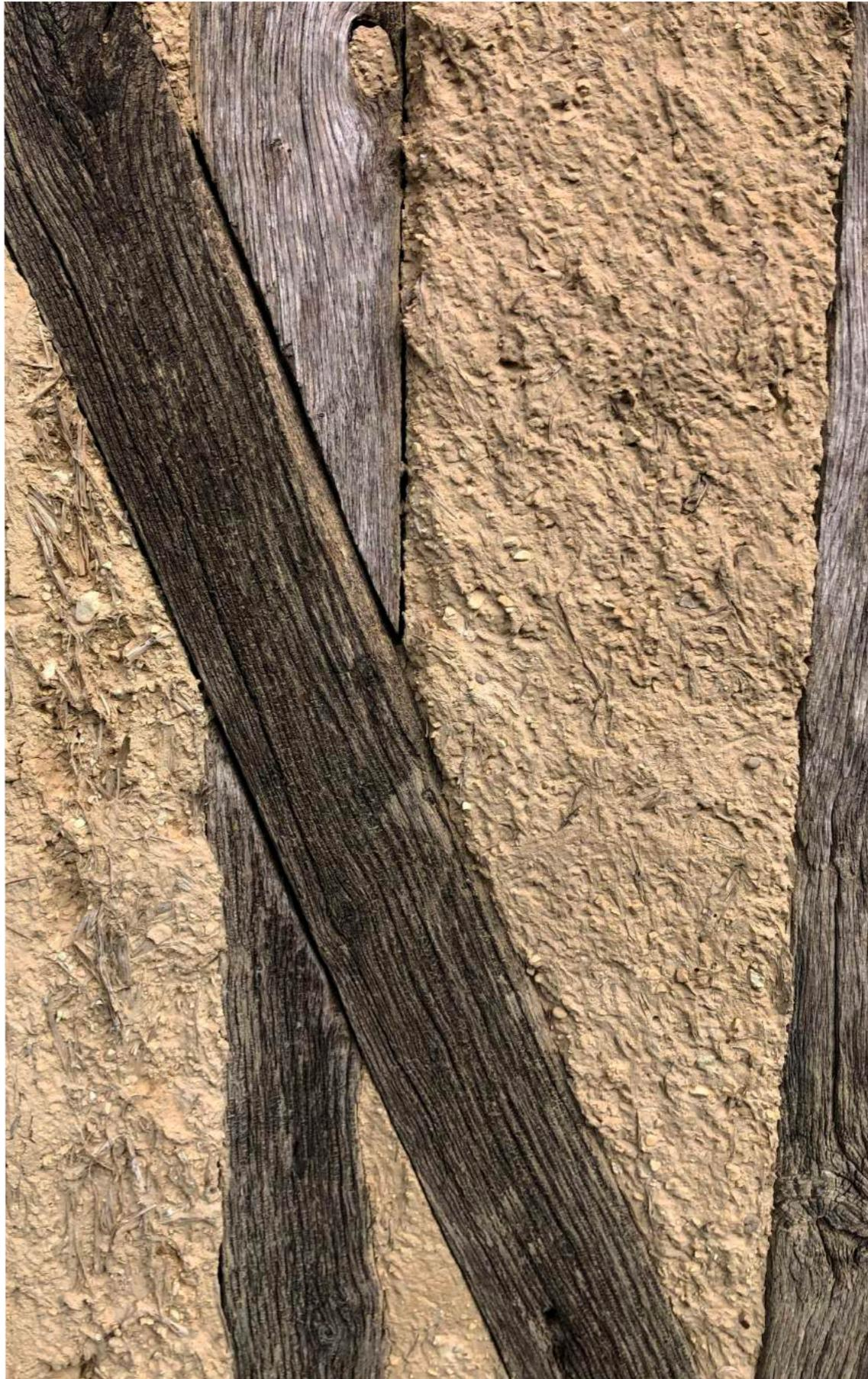
*Torchis extérieur recouvert d'enduit à la chaux*
