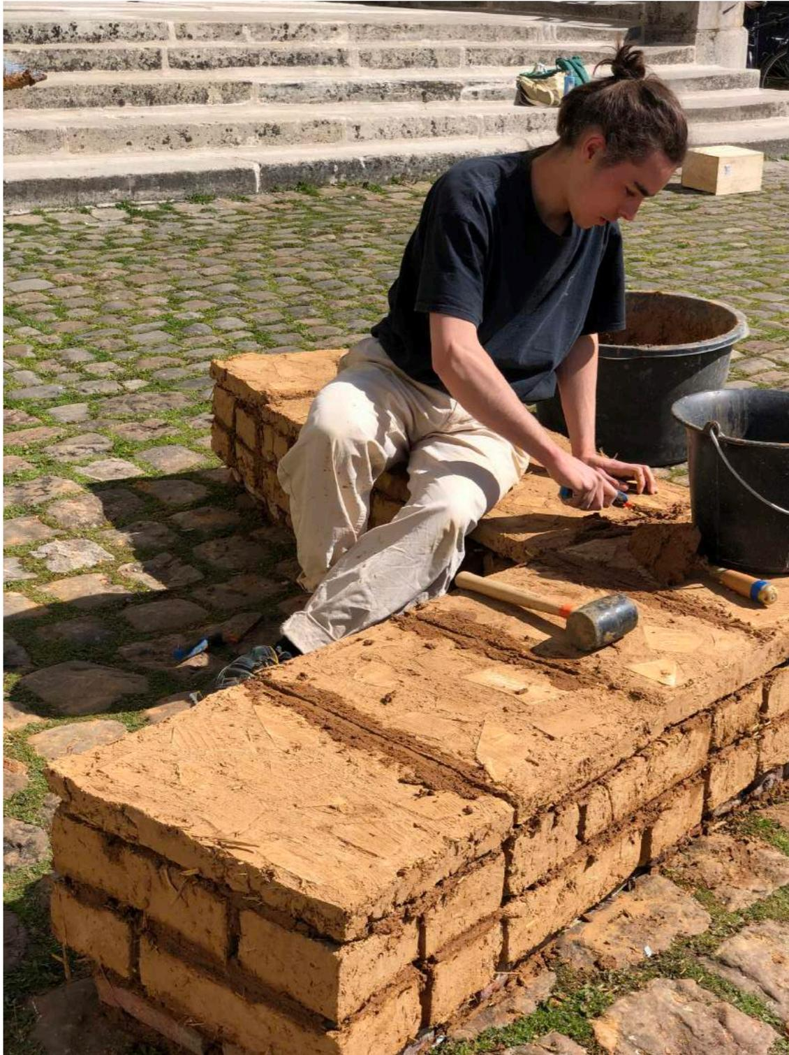
Recouvrement des briques par des briques chapeaux qui servent de finition et de protection des modules
