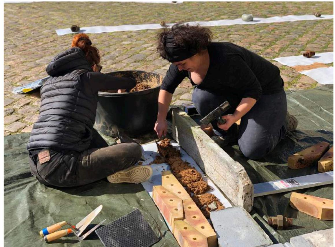
Démonstration d'Adeline Houssack pour la maçonnerie du soubassement en matériau de récupération
