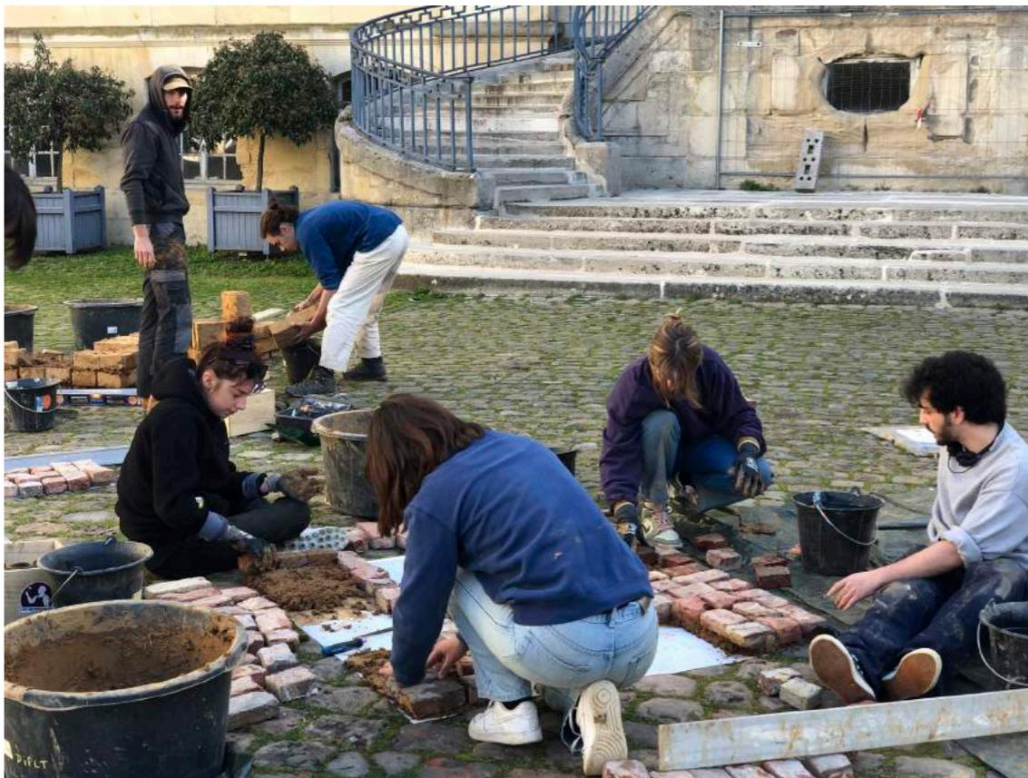
Soubassement réalisé avec les briques cassées récupérées chez un particulier à quelques kilomètres de Reims
