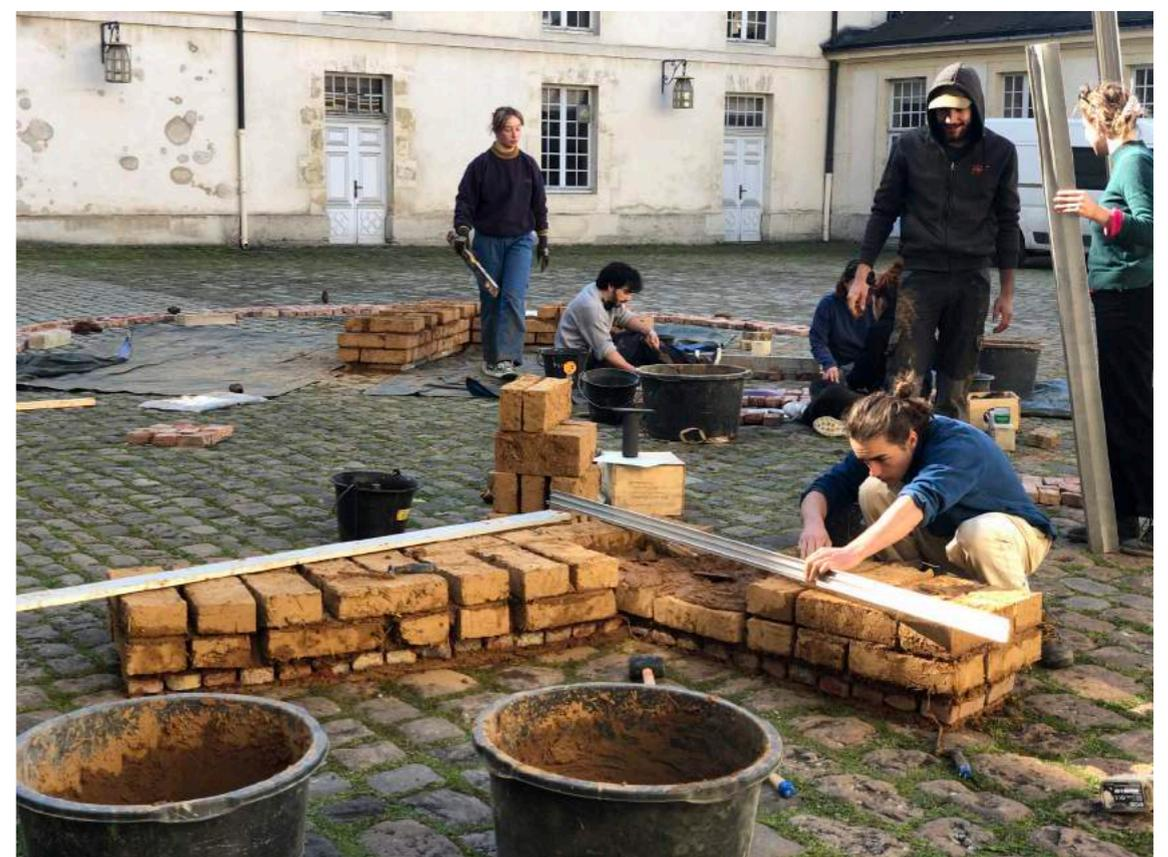
Mise à niveau du second étage de brique
