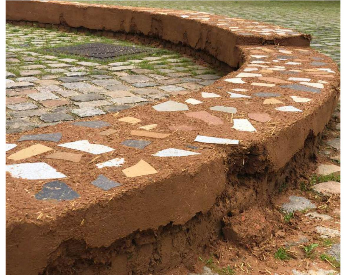
Dernier module construit avec les briques façon pisé (moins d'eau utilisée, peu de fibre), l'une d'elles est tombée.
