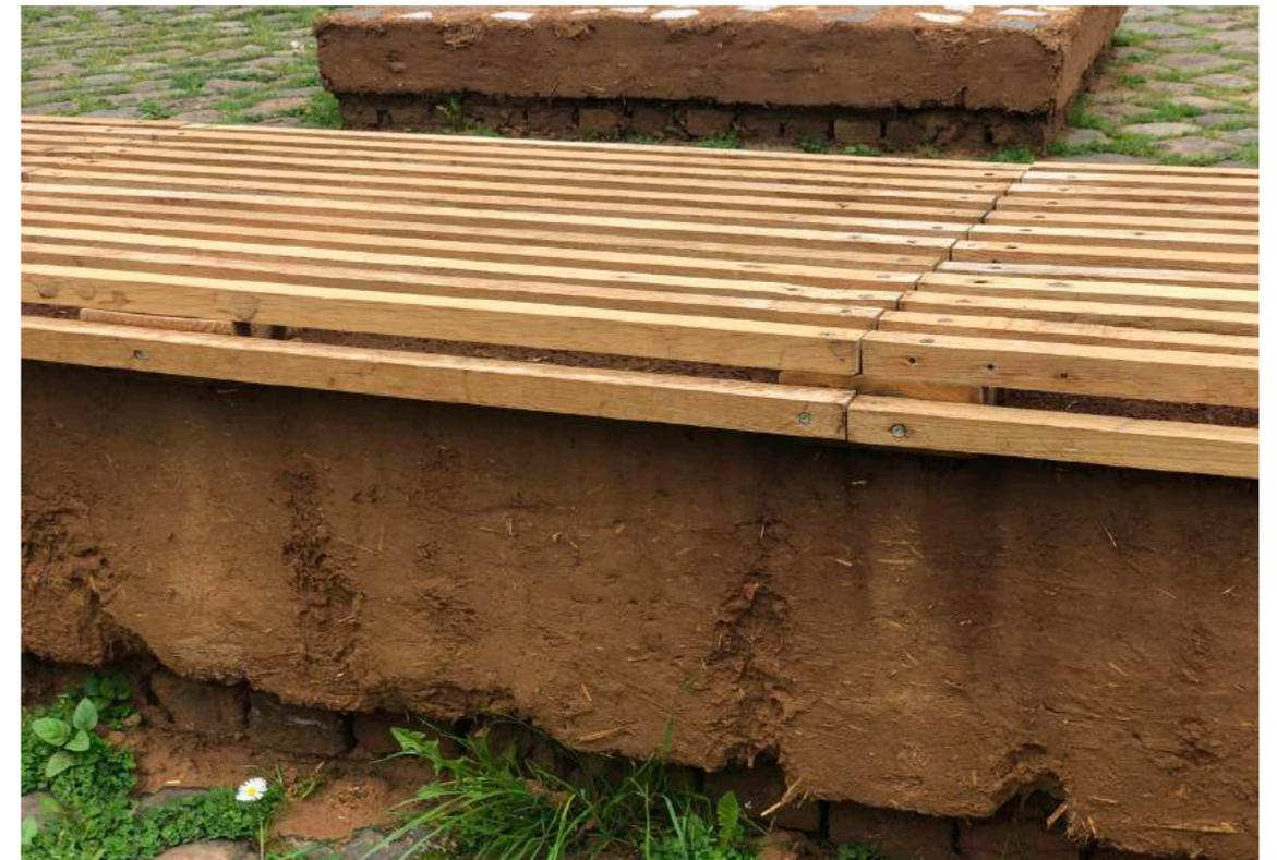
Le bas des enduits s'effrite, cela correspondant souvent aux espaces du mortier. Ce phénomène est moins visible sur les modules d'assise car la couverture en bois présente une meilleure protection.
