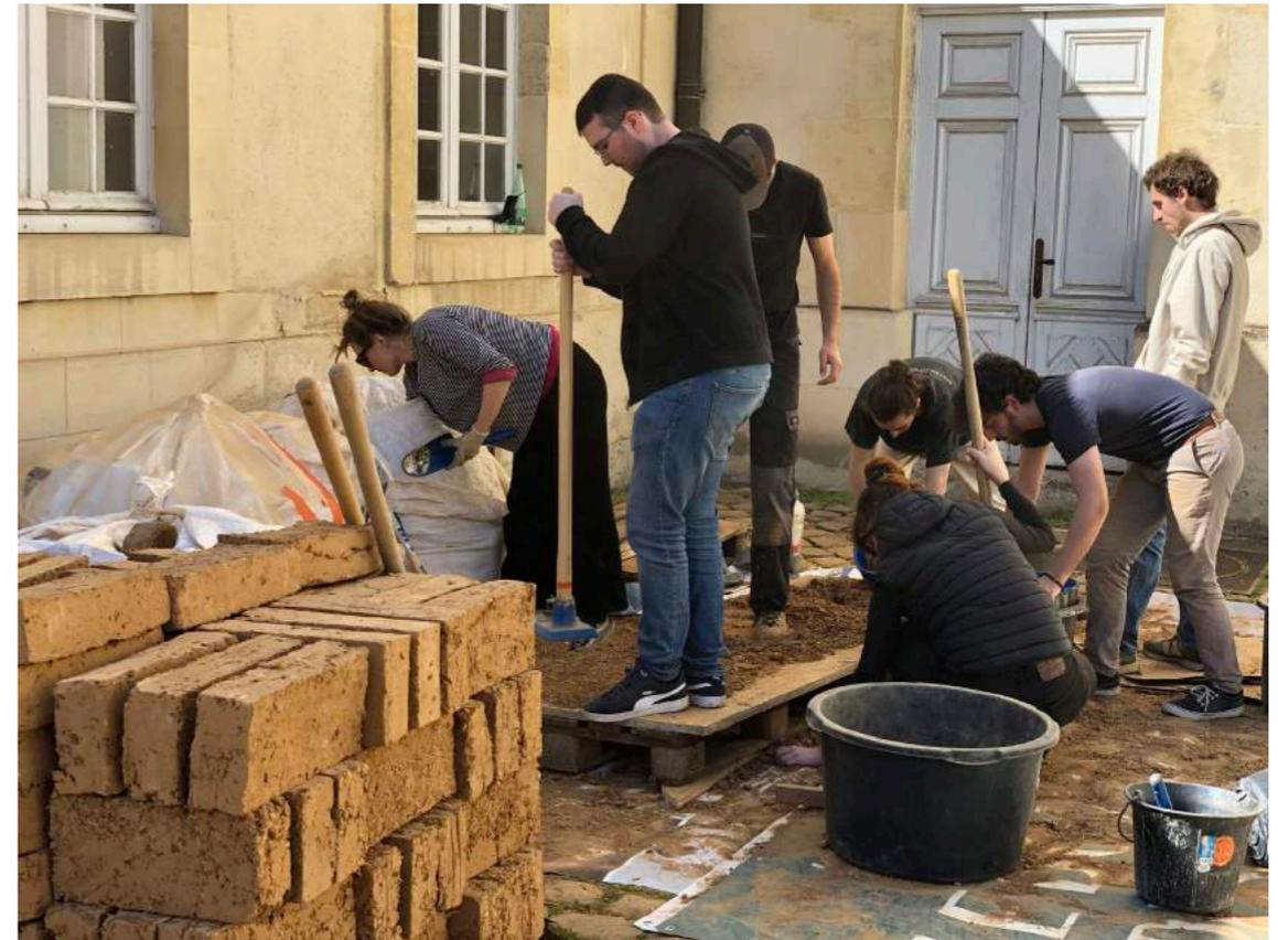
Préparation de la terre pour le mortier et les enduits
