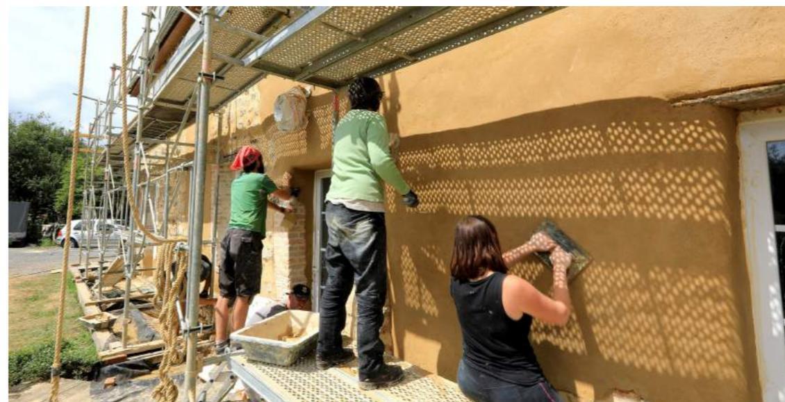
Chantier Enerterre, enduit extérieur
