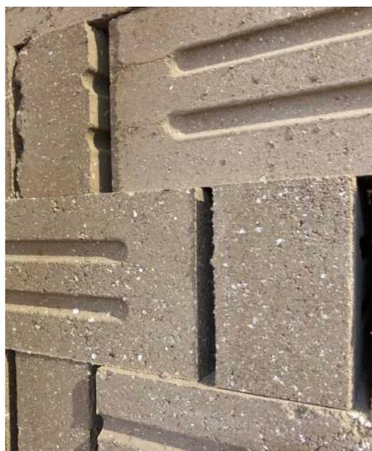
Blocs de terre comprimée (BTC) réalisés par Cycle Terre
