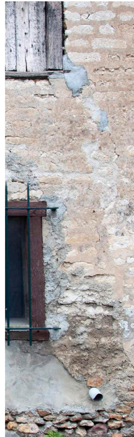
Façade en terre crue dégradée par une rénovation à base de ciment à Villers-aux-Nœuds (51), 2022
