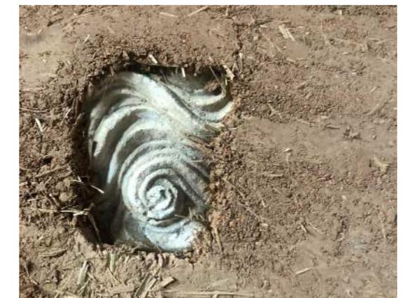
Fragment de pierre calcaire incorporé dans une des colonnes en terre crue.
