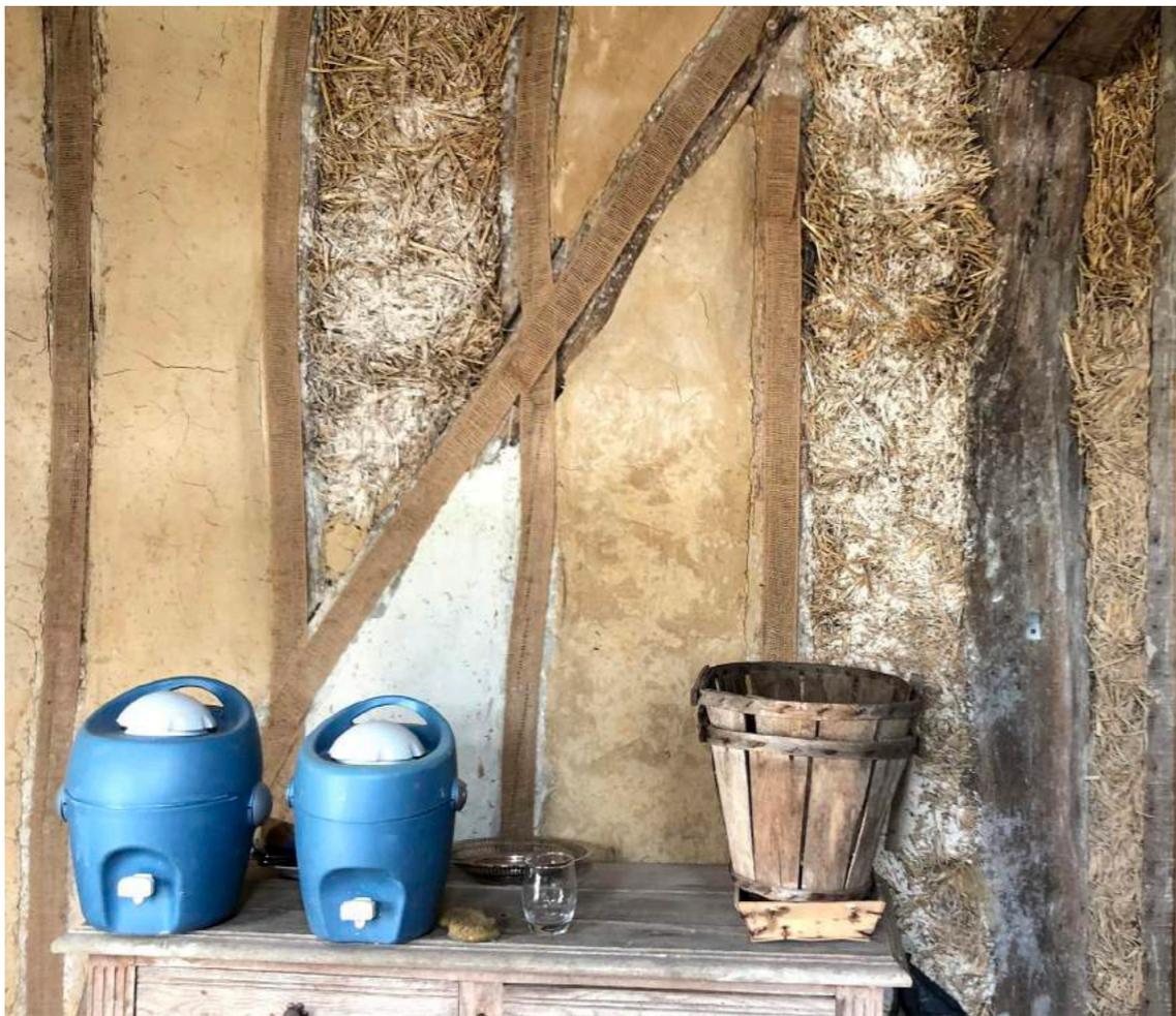
*Torchis intérieur recouvert d'enduit, enduit intérieur sur pan-de-bois.*
