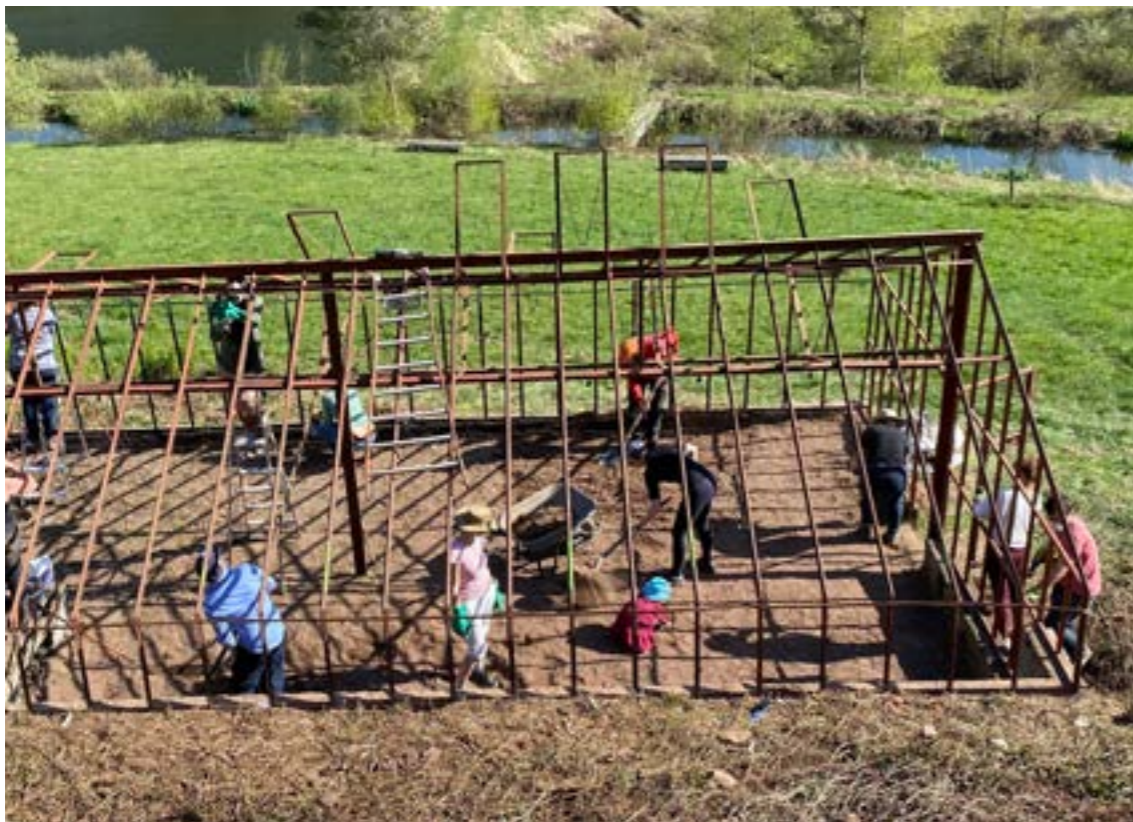
Chantier participatif durant la construction de la serre aquaponique
