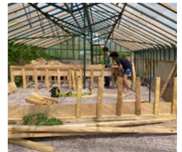
Chantier participatif de la serre aquaponique source : https://lavigottelab.org
