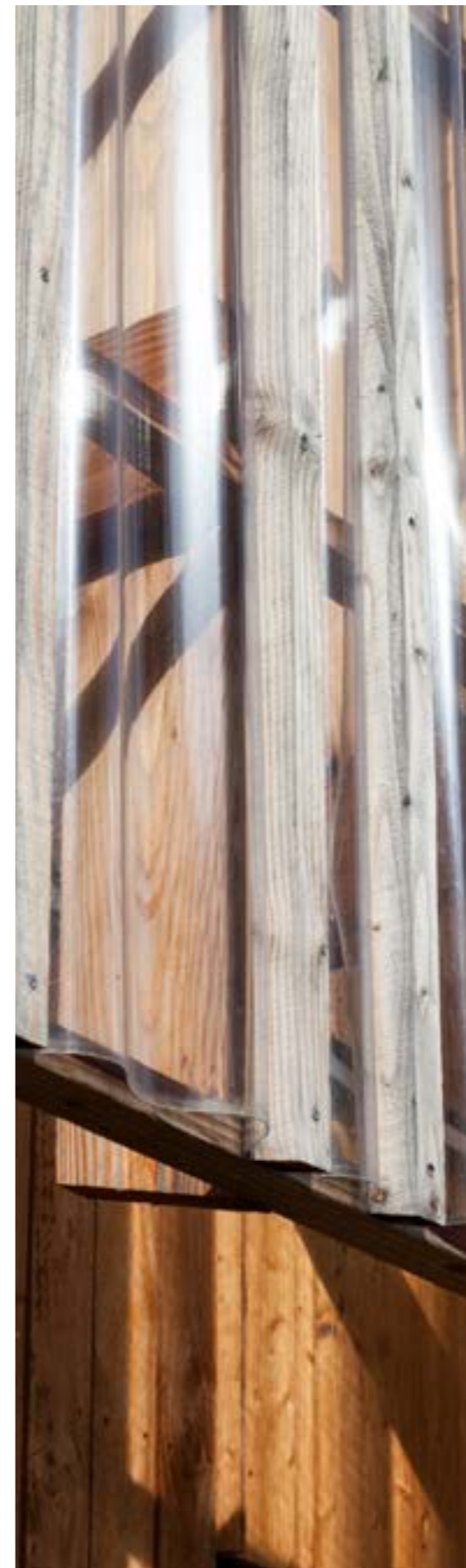
Détails extérieurs, en douglas, de l'Hôtel de l'Innovation pour le Bois
