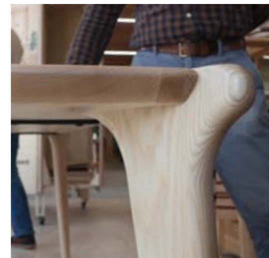
Détail de l'assemblage pied et plateau https://helce.fr/
