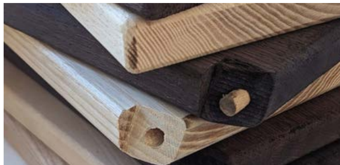
Détail des assemblages avec tourillons
