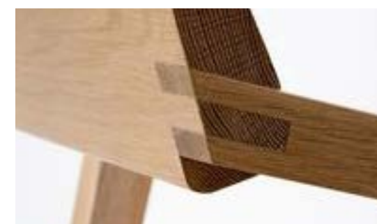
Assemblages en tenon-mortaise
