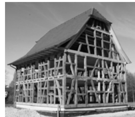
Montage d'une maison alsacienne à colombage dans le village de Berentzwiller, © Denis Sollier
