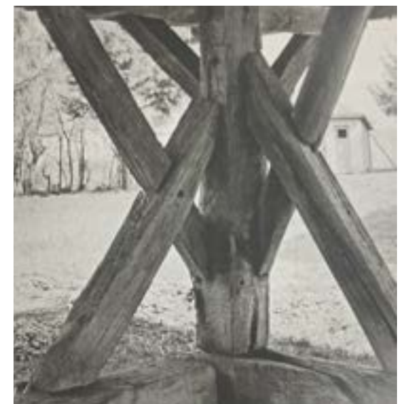
Détail de charpente révélant la rencontre des poutres et leur assemblage
