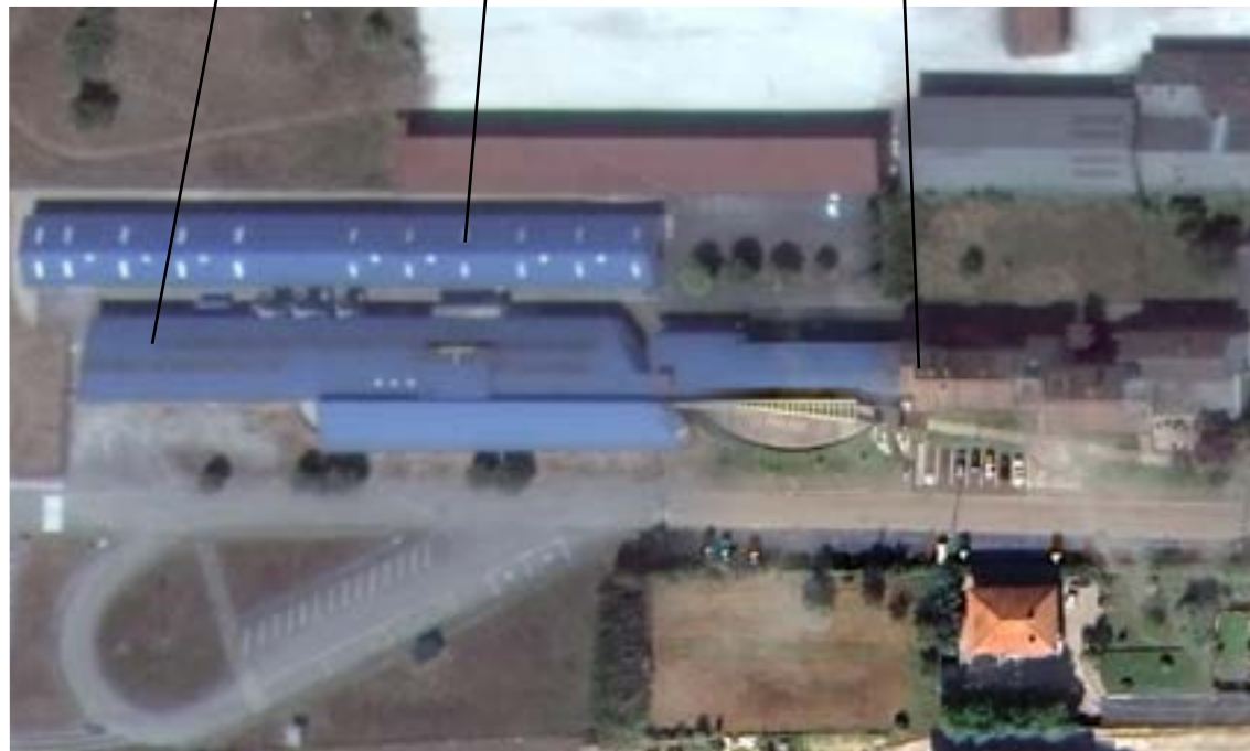
Photographie satellite des bâtiments, Google Earth
