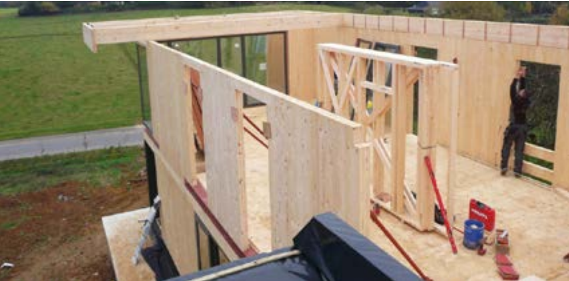
Construction avec les panneaux en CLT, source https://www.stabilame.be/systemes-constructifs/clt-colle
