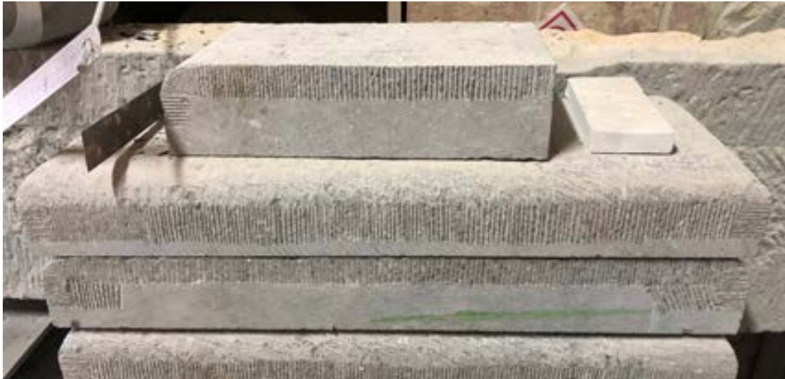
Ciselure sur chant permettant l'écoulement de l'eau
