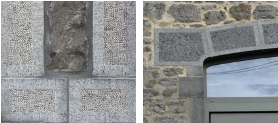
Détails des pierres taillées par Christophe Mahy et intégrées sur les façades des bâtiments du village
