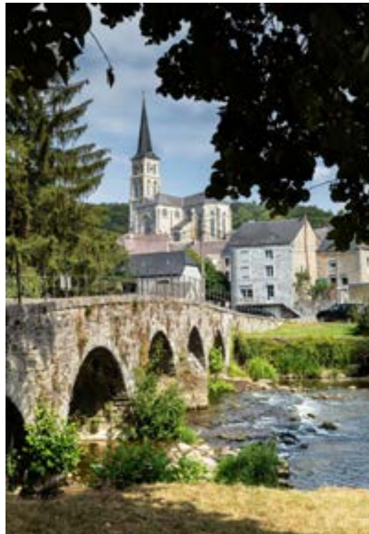
Le pont du clocher à Viroin
