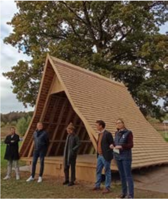
Le kiosque multiservices rural en chêne dans les Ardennes, conçu par l'agence d'architecture Encore Heureux ( encoreheureux.org )
