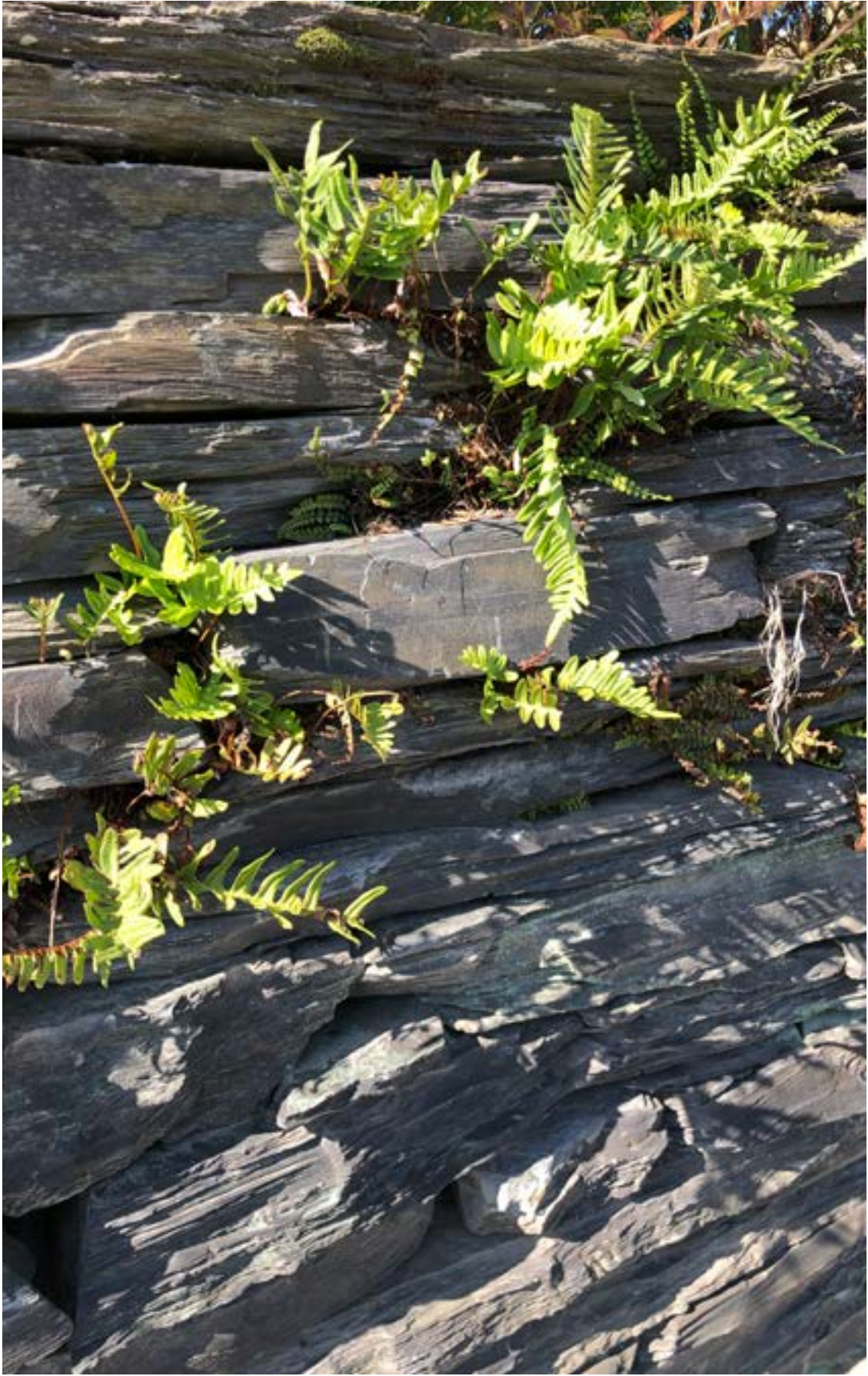
Mur en ardoise brute, vu dans la ville de Rimogne
