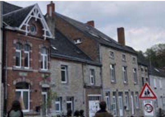
Façades et toitures des bâtiments de Nismes
